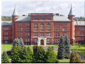
Budynek COS SG w Koszalinie.
